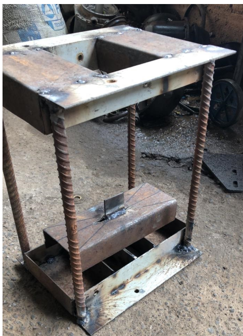
Figura 5 – Soldagem da estrutura
