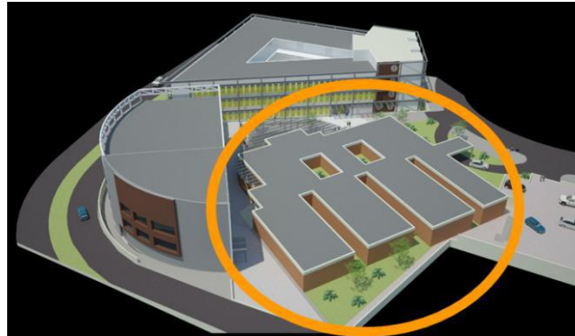
Figura 4 - Expansão, vista Bloco I (BOAS, 2010).
