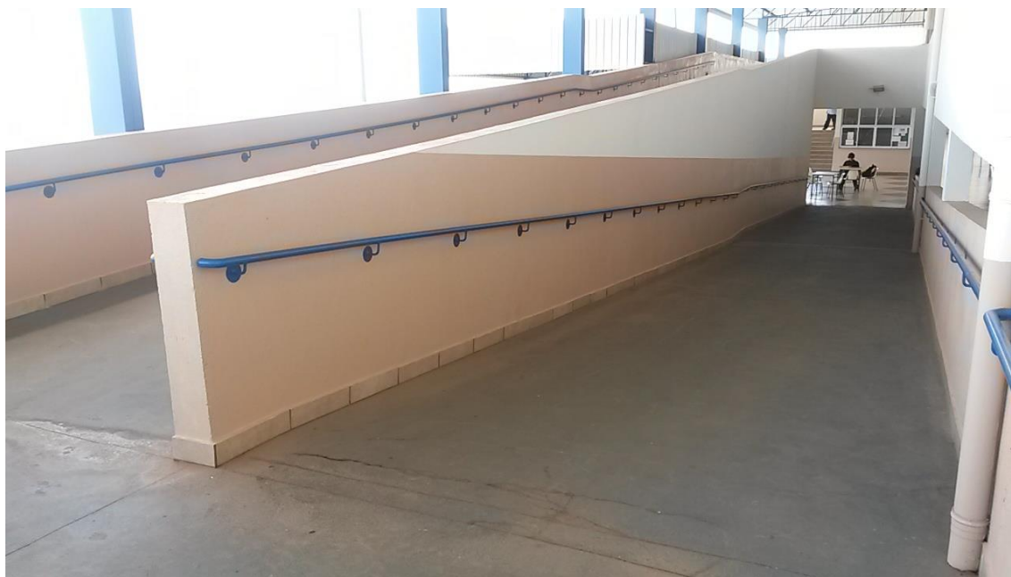
Figura 6 - Rampa de acesso ao segundo andar
