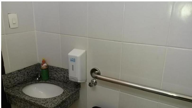
*Figura 7 - Detalhe do banheiro para P.N.E. - Barras de apoio instaladas.*
