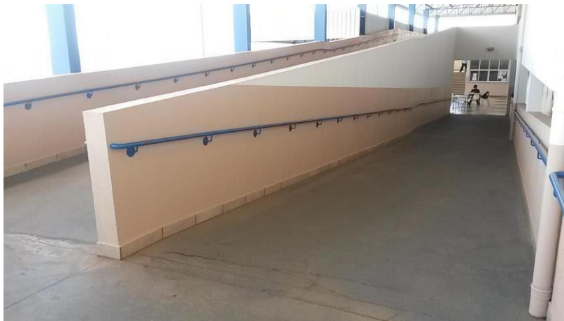
Figura 1 - Rampa de acesso ao segundo andar
