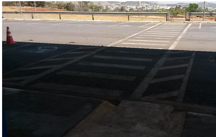
Figura 5 - Rampa de acesso às dependências da instituição
