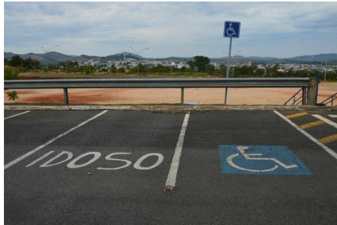
Figura 3 - Vagas para pessoas com necessidades especiais
