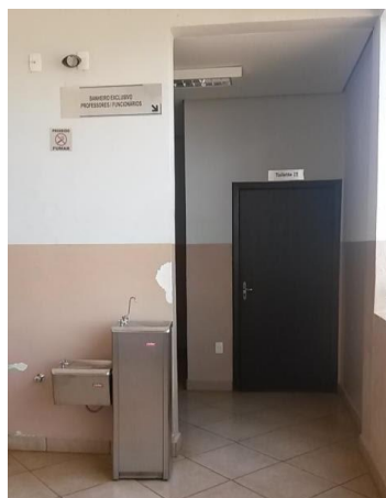
Figura 6 - Vista geral do banheiro para P.N.E
