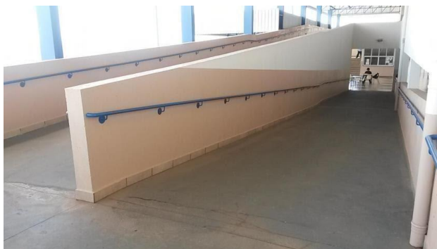
Figura 1 - Rampa de acesso ao segundo andar
