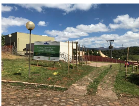
FIGURA 15: Obra da Cantina, em andamento Fonte: DInfra
