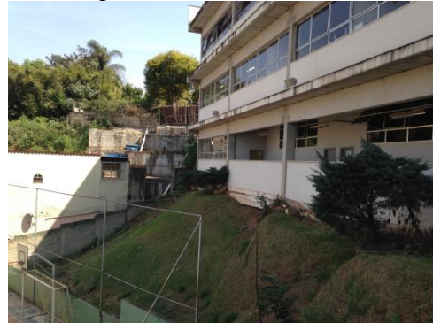
FIGURA 33: Vista Externa da sala. Fonte: DInfra
