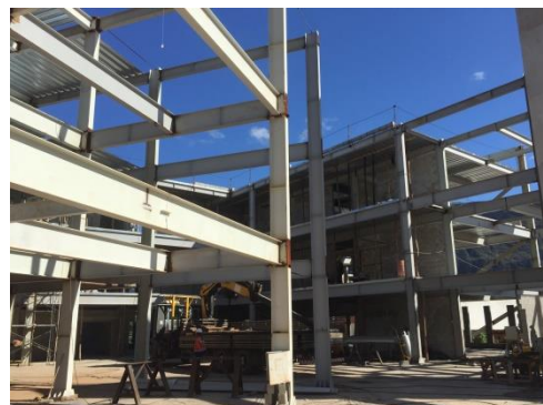
FIGURA 35: Vista Externa 2 – Obra de construção do Bloco Didático Fonte: DInfra
