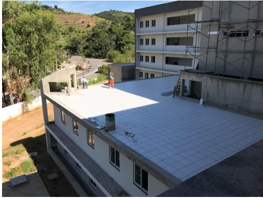
FIGURA 40: Vista Exterior Obra do Bloco Didático
