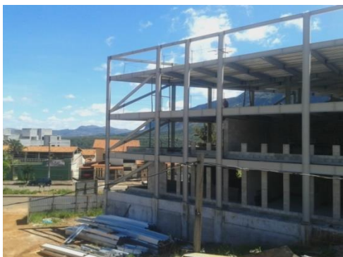
FIGURA 34: Vista Externa 1 – Obra de construção do Bloco Didático Fonte: DInfra
