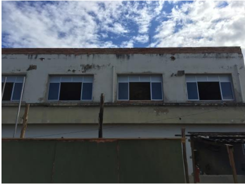
FIGURA 30: Vista Externa – Obra de Reforma do Campus Avançado Ipatinga Fonte: DInfra
