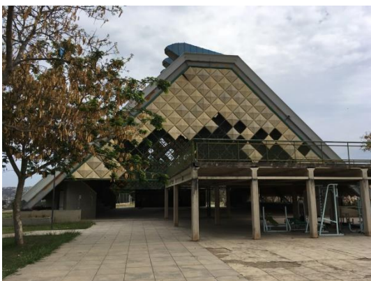
FIGURA 7: Vista Ginásio e área de convivência. Fonte: DInfra
