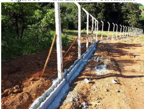
Figura 30 - Vista Lateral 1 - Cercamento
