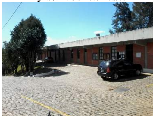
Figura 87 - Vista Bloco Didático
