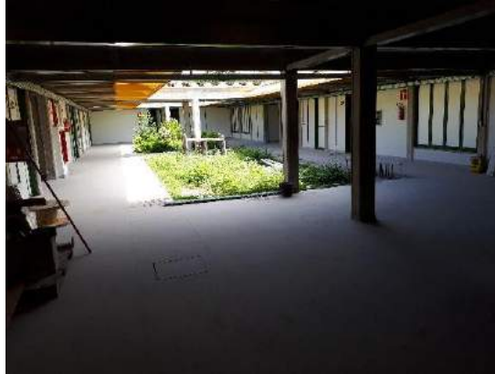
Figura 74 - Vista interna ó Bloco III
