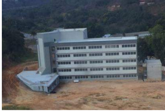
Figura 116 - Vista geral da obra
