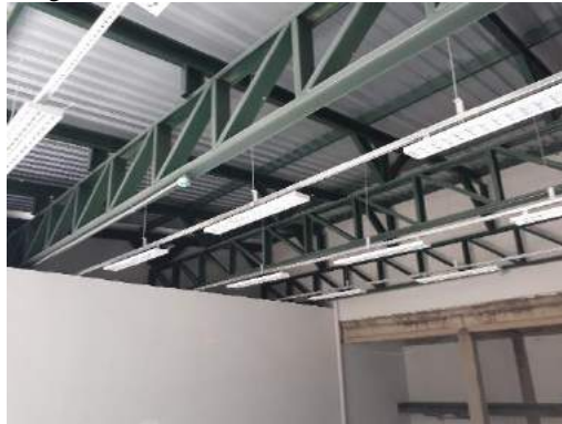
Figura 76 - Vista interna ó Cobertura Laboratório
