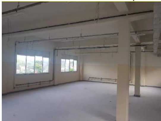
Figura 40 - Vista interna reforma Laboratórios do Campus Avançado Ipatinga
