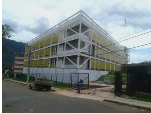
Figura 49 - Vista Externa 2 ó Bloco Didático
