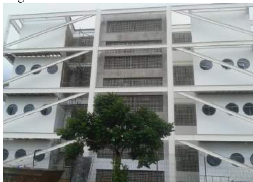
Figura 48 - Vista Externa 1 ó Bloco Didático
