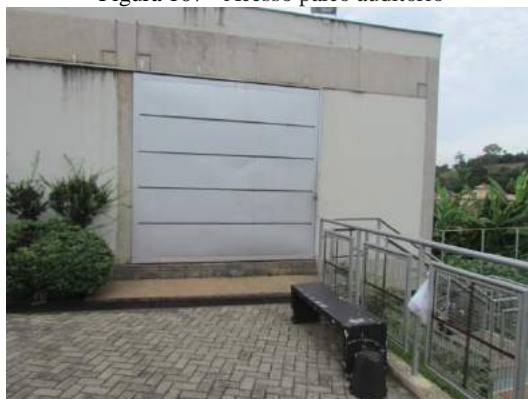
Figura 107 - Acesso palco auditório
