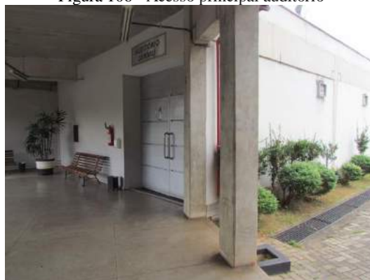
Figura 106 - Acesso principal auditório
