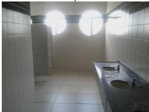
Figura 52 - Vista interna Instalações Sanitárias do Bloco Didático
