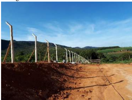
Figura 28 - Vista Frontal 1 - Cercamento
