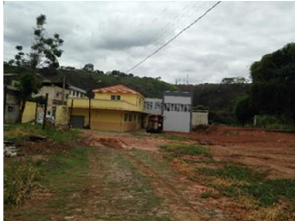
Figura 61 - Vista geral edificação Campus Avançado Ponte Nova
