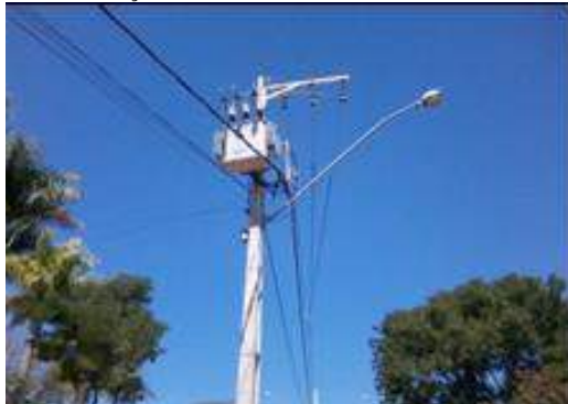
Figura 84 - Instalação de transformadores em São João Evangelista
