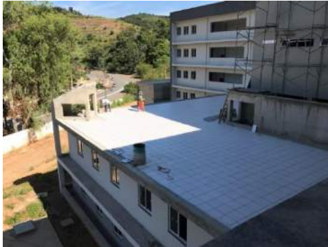
Figura 117 - Vista exterior do Bloco Didático
