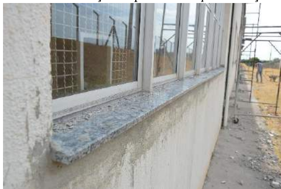
Figura 58 - Vista instalação de peitoril Campus Avançado Piumhi
