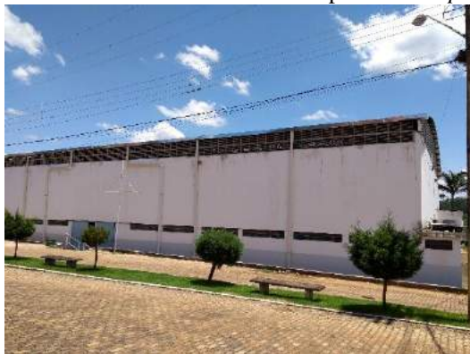
Figura 24 - Vista externa do Ginásio Poliesportivo Campus Bambuí
