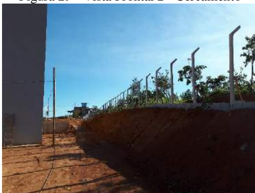
Figura 29 - Vista Frontal 2 - Cercamento
