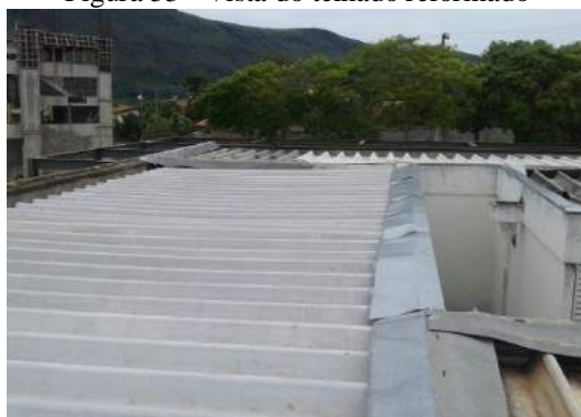
Figura 53 - Vista do telhado reformado
