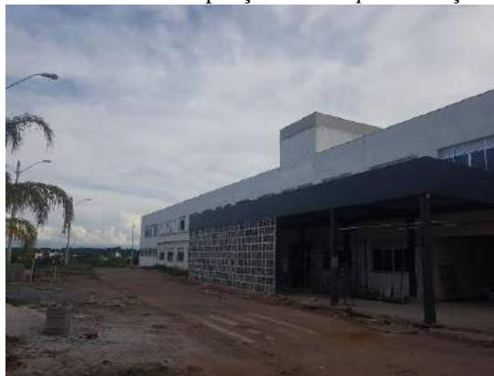
Figura 39 - Vista externa ampliação do Campus Avançado Ipatinga
