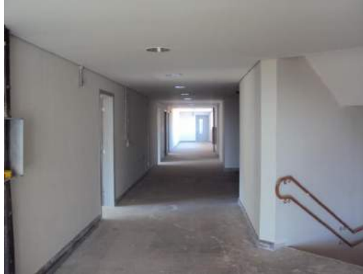
Figura 97 - Circulação , hall elevadores e escadas
