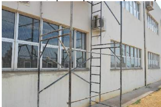
Figura 57 - Vista lateral, reparos esquadrias Campus Avançado Piumhi
