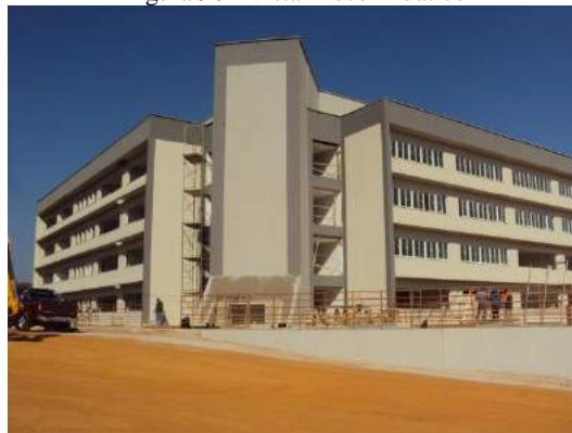
Figura 96 - Vista Bloco Didático
