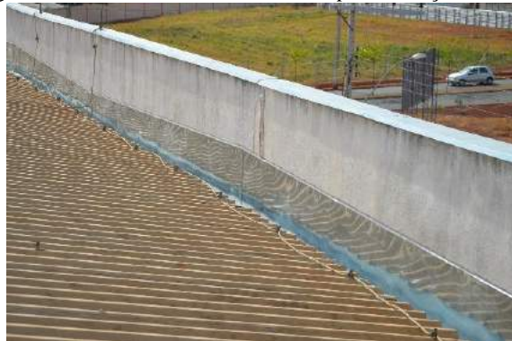
Figura 56 - Vista telhado e calha Campus Avançado Piumhi
