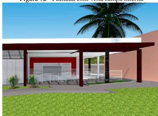
Figura 92 - Fachada com vista rampa interna
