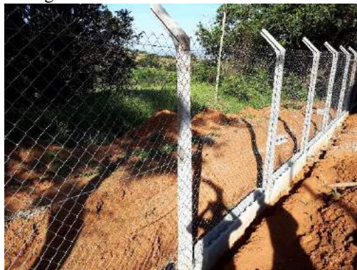
Figura 31 - Vista Lateral 2 - Cercamento
