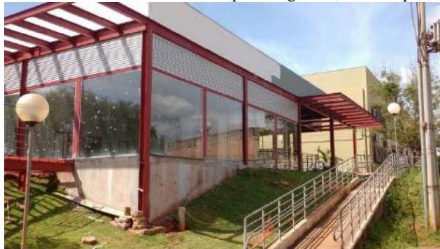
Figura 25 - Vista externa da reforma da Cantina do Campus Congonhas, com rampa lateral para acessibilidade
