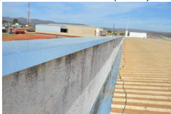
Figura 55 - Vista reforma telhado Campus Avançado Piumhí
