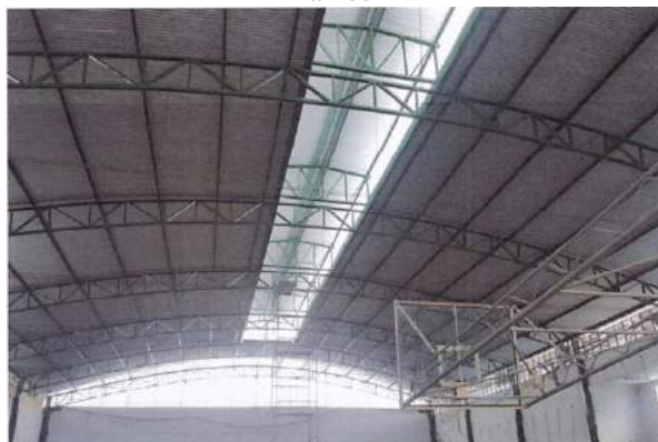
Figura 22 - Vista da estrutura metálica e lanternim da Cobertura do Ginásio Poliesportivo do Campus Bambuí
