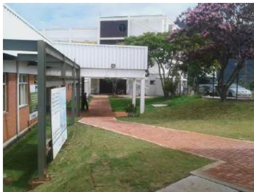
Figura 47 ó Vista externa do Tratamento de fachada do Bloco 1
