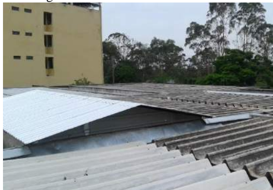
Figura 54 - Vista do telhado reformado
