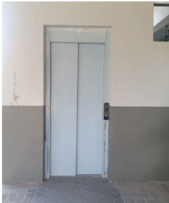
7. Elevador itabirito-Contrato 53/2022 Valor da obra - R$261.702,57 - Finalizada
