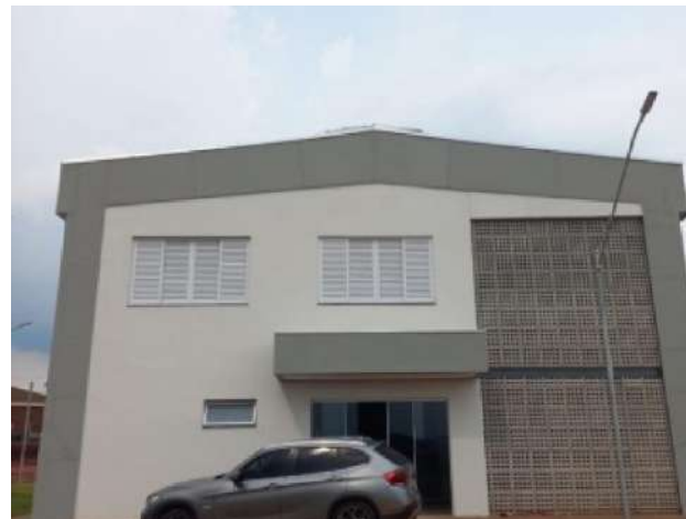
FIG. 07: GALPÃO DE ENSINO DO CAMPUS PIUMHI
