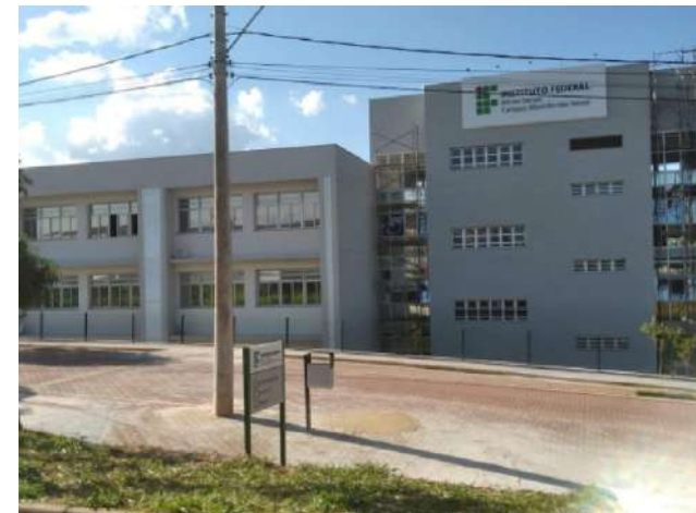
FIG. 08: CONSTRUÇÃO DO BLOCO DIDÁTICO E ADMINISTRATIVO DO CAMPUS RIBEIRÃO DAS NEVES
