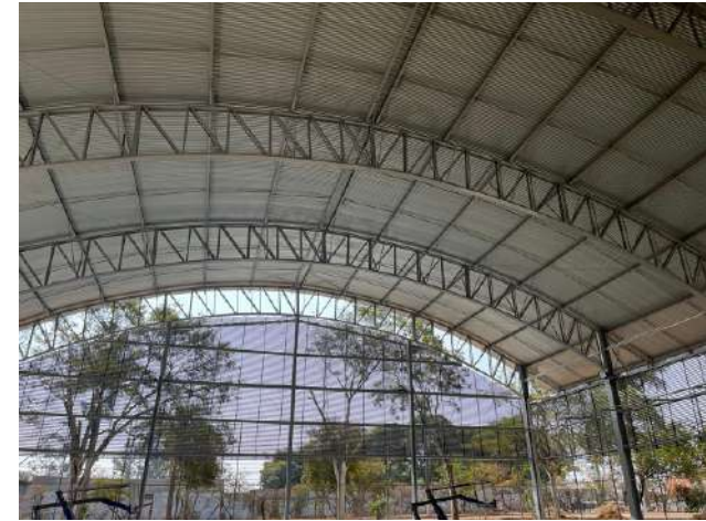
FIG. 05: QUADRA POLIESPORTIVA DO CAMPUS ARCOS
