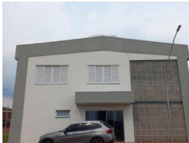
FIG. 07: GALPÃO DE ENSINO DO CAMPUS PIUMHI
