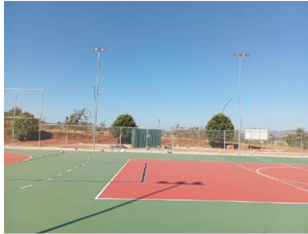
FIG. 04: QUADRA POLIESPORTIVA DO CAMPUS PIUMHI
