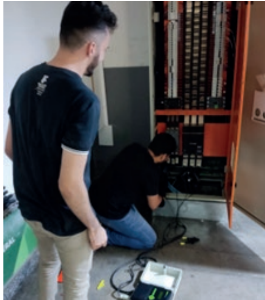
Figura 3 . Fotografia da instalação do analisador de qualidade de energia
