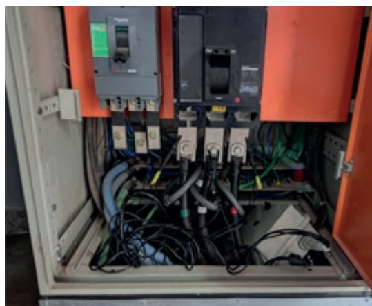
Figura 2 . Fotografia do analisador de qualidade de energia instalado para a medição no QGBT
