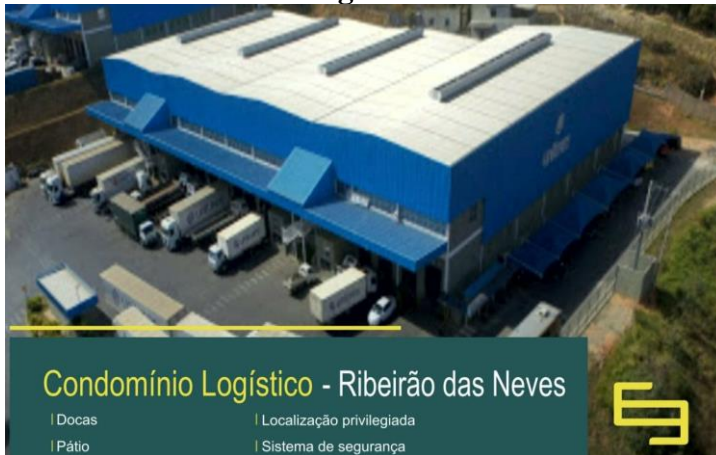
Foto 1 – Condomínio Logística Ribeirão das Neves
