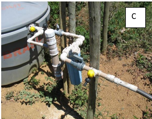
Figura 1. Versões dos cloradores de passagem artesanal utilizados nas propriedades rurais. Primeira versão (1A); segunda versão (1B) e terceira versão (1C) e filtro de água industrial (1D).
