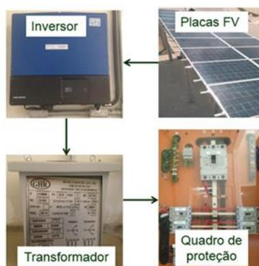
**Fig. 2: Elementos fundamentais da Usina Fotovoltaica.**
